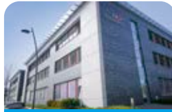
Volterion Dortmund Energiespeicher-Systeme
